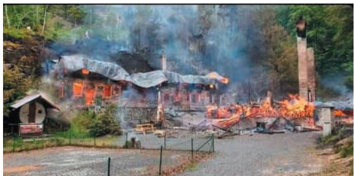
Lovecké chaty Na Tokání před požárem a po požáru...
