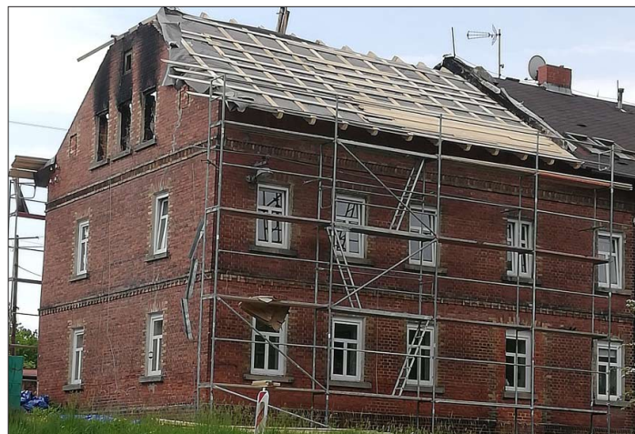
Práce na vyhořelém domě č.p.104
