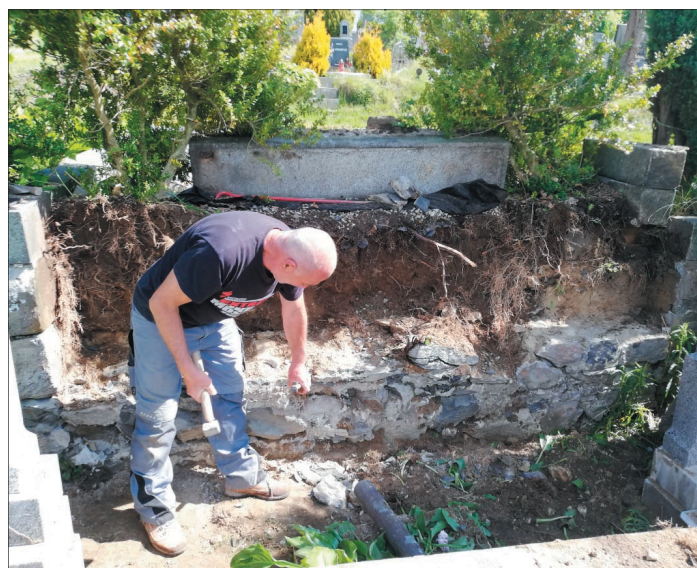
Oprava zdi na chřibském hřbitově
