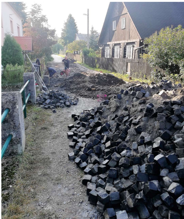
Rekonstrukce dláždění místní komunikace
