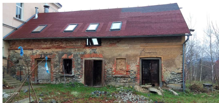
Č.p. 255 před rekonstrukcí...
