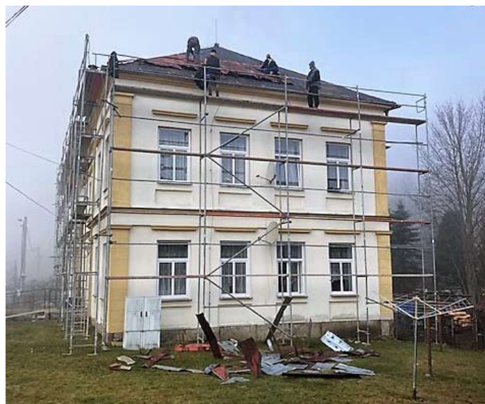
Výměnu střešní krytiny na č.p. 46 v Horní Chřibské provádí společnost Klempířství Ilčíková. (Cena 392 700 Kč bez DPH)
