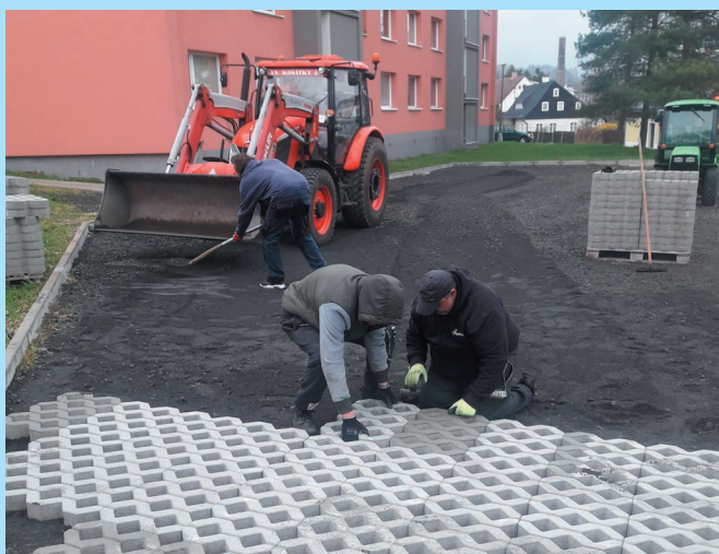
Zaměstnanci obce provádějí pokládku zatravnovací dlažby na parkovišti u panelových domů.
