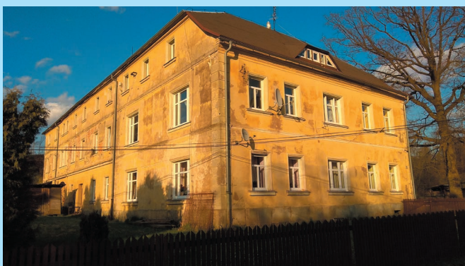
Na městském době č.p. 56 (bělidlo) byla dokončena výměna všech oken.
