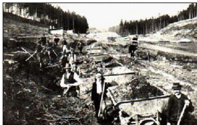
Práce na stavbě chřibské přehrady
