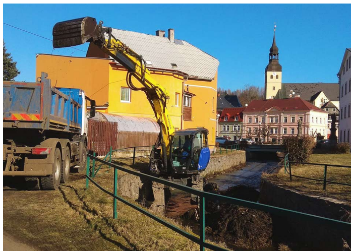
Čištění koryta potoka povodí Ohře. (foto MN)
