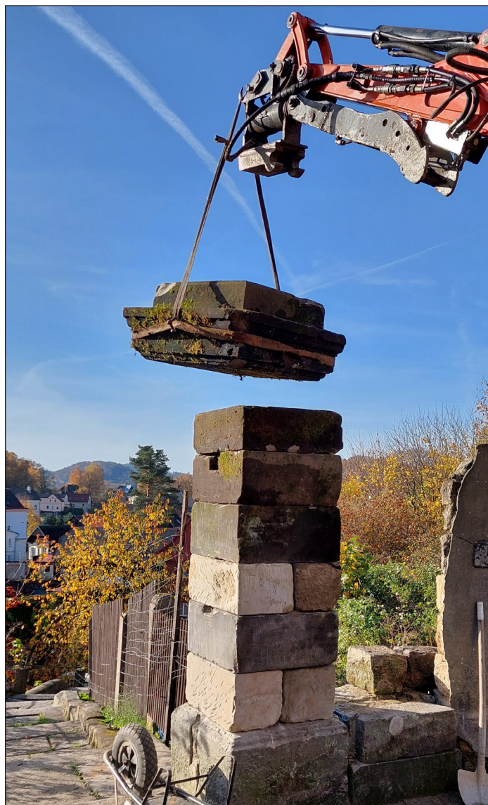
Oprava sloupu u vstupní brány vedle fary (foto VF)
