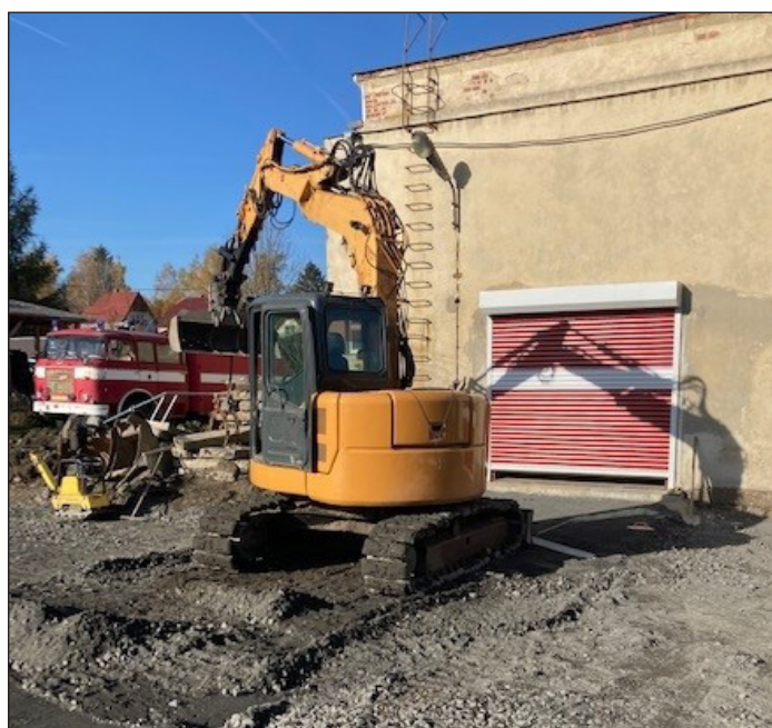
Rekonstrukce manipulačních ploch u hasičské zbrojnice (foto Nep)
